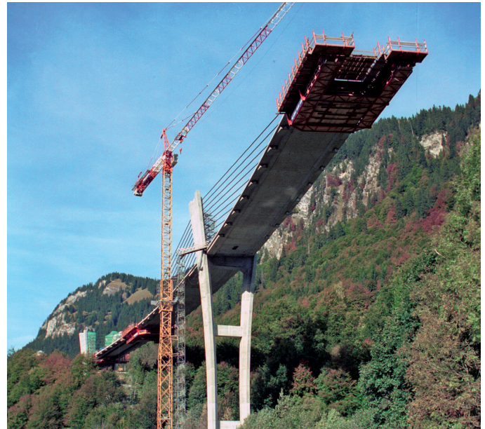
Sunnibergbrücke im Bauzustand mit Freivorbauwagen
